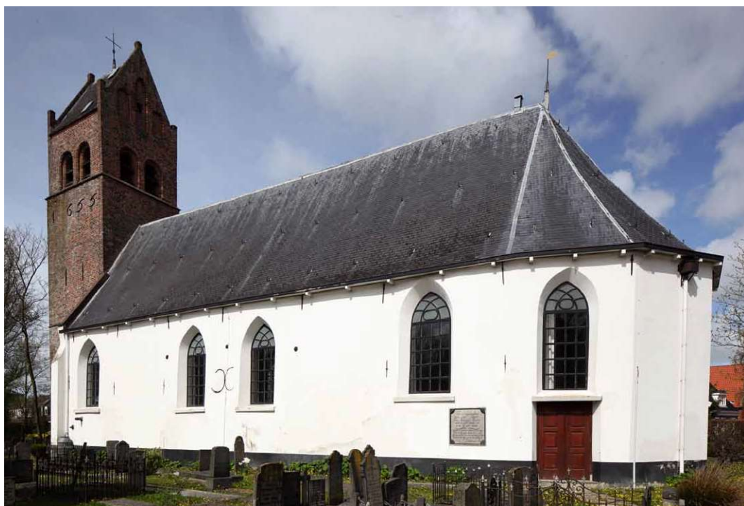
Exterieur uit zuidoost | Exterior from the south-east | Außenansicht von Südosten
